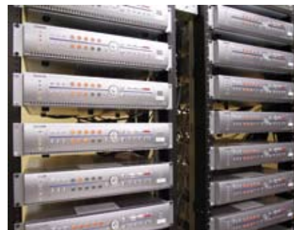
■問題を再生および分析するため、カジノの全カメラ映像は30fpsで記録する。
