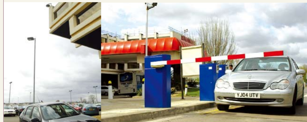
■駐車場のアクセスコントロールは客の安全を確保するだけでなく、入退する人達の身分も確認できる。
