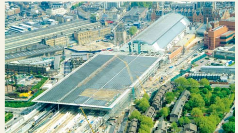
St. Pancras International駅：IPネットワークソリューションにアップグレードしたCCTVシステム。(写真提供：London & Continental Railways)
